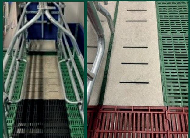
Betonschlitzte in Kombination mit Gussroste und Kunststoffroste
