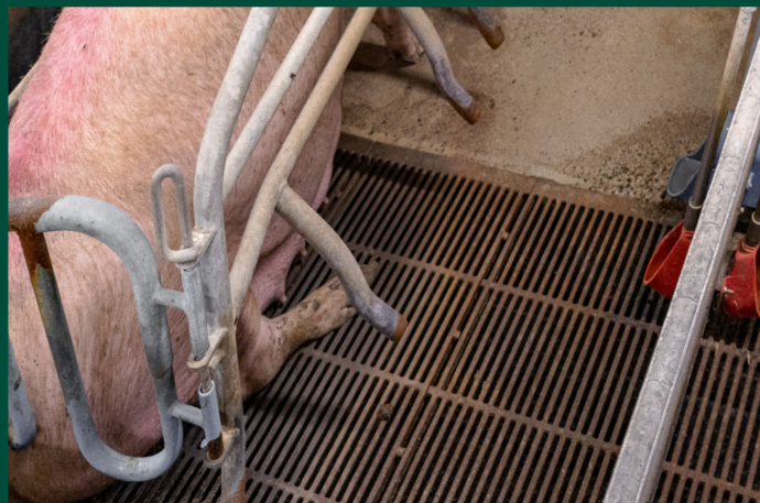
Selvbærende støbejernsrist til farestien (11/10 mm)
