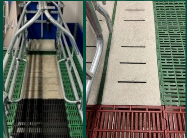
Betonspalter i kombination med støbejern og plastriste
